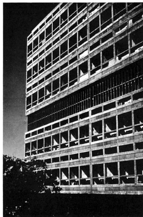
Unité d'Habitation, Marseille. Photos by Rudi Baumfeld
